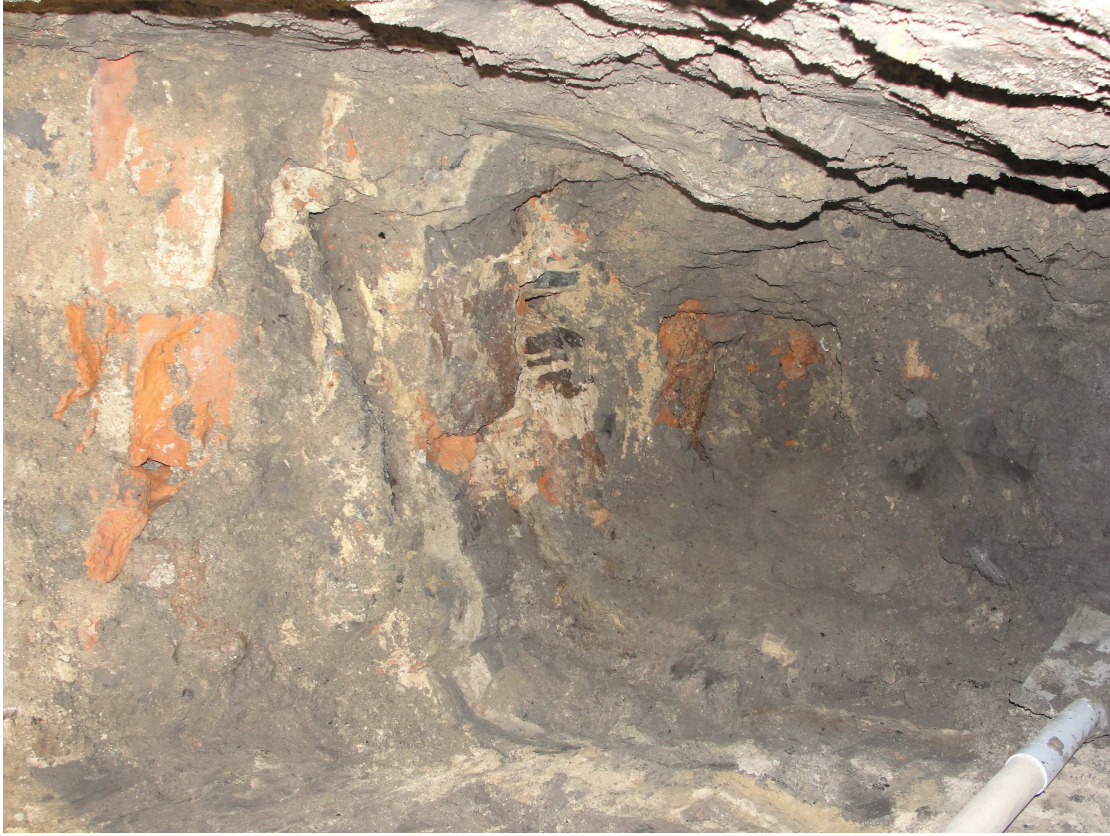
ZDJĘCIE NR.2 ODKRYWKA FUNDAMENTU POD ŚCIANĄ CZ. STARSZEJ
