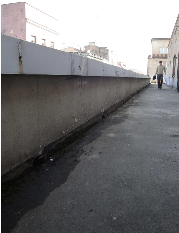
ZDJĘCIE NR.9 PĘKNIĘCIE JEDNEJ Z ARKAD
